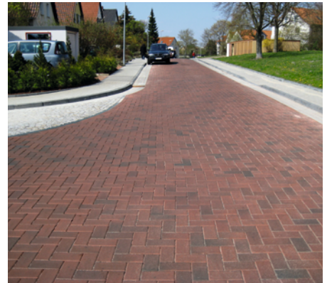
Klinkerpflasterfläche mit Verkehrsbeanspruchung
