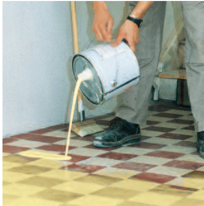
PCI Gisogrund 303 gründlich aufschütteln und auf den Untergrund ausgießen.
