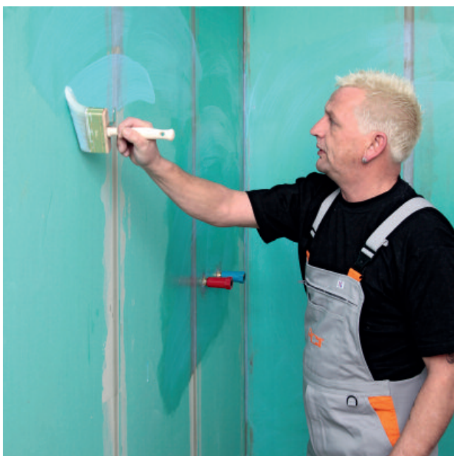
1. Grundieren: Saugende mineralische oder gips haltige Untergründe und Gipskartonplatten mit PCI Gisogrund grundieren.
