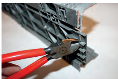
Kürzen des Rinnenendes im Bodenbereich
