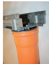
Anschließen des KG-Rohres DN 100
