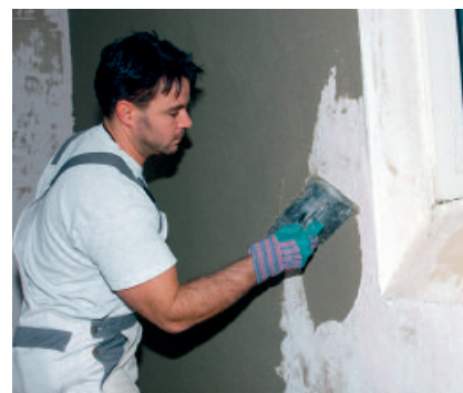
PCI Pericret lässt sich sehr geschmeidig verarbeiten - in Schichtdicken von 3 bis 50 mm.
