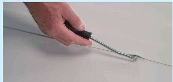
Nahtkontrolle mit Prüfnadel.
