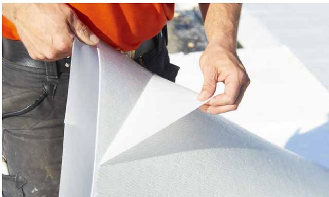
Tectofin SK - einfach Schutzfolie abziehen
