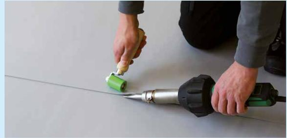
Flächennähte können mittels Heißluft (Handgerät oder Automat) verschweißt werden. Im Detailbereich wird generell mit Heißluft geschweißt, z. B. Innen- und Außenecken, T-Stöße oder Rohreinfassungen.
