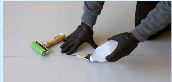
Alternativ können Flächennähte auch mit Quellschweißmittel verschweißt werden: Zwischen die mindestens 4 cm breiten Bahnüberlappungen wird das Witec Quellschweißmittel mit leicht reibenden Bewegungen des Pinsels eingebracht und der Nahtbereich anschließend mit einer Rolle angedrückt.
