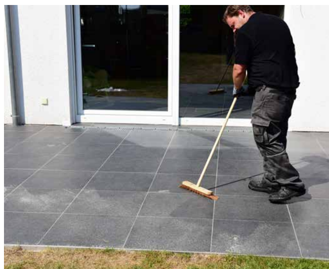
16 ... und Mörtelreste ggf. abkehren.
