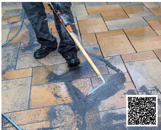
Verfugung von Betonwerksteinplatten mit Sopro Solitär® F 20.
