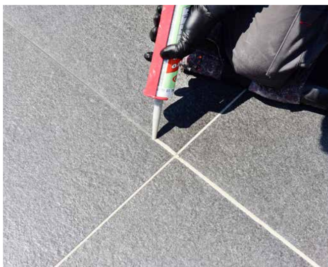
17 Anschluss- und Bewegungsfugen einbringen.
