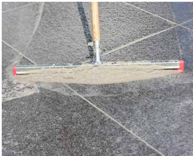
13 ... und mittels Gummischieber in die Fuge einbringen.
