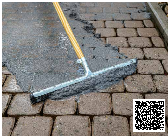
Sanierung einer Pflasterfläche mit Sopro Solitär® F 20.
