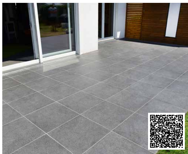
18 Die verfugte Oberfläche ist nach 24 Stunden begehbar.
