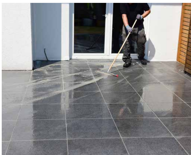
15 Überschüssigen Fugenmörtel abtragen ...
