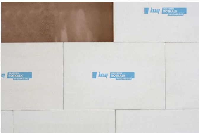
Bild 6: Plattenverlegung in Fläche
