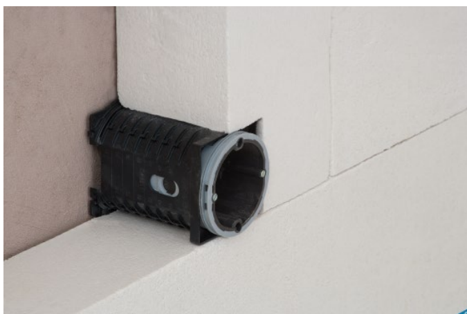
Bild 13: Einbau von Elektrodosen
