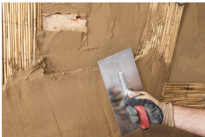
Bild 2: Untergrundvorbereitung bei Fachwerkkonstruktionen
