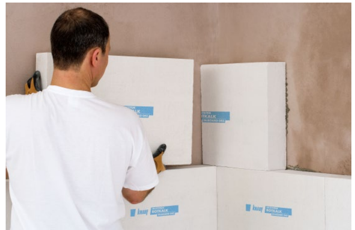
Bild 8: Plattenverlegung im Eckbereich
