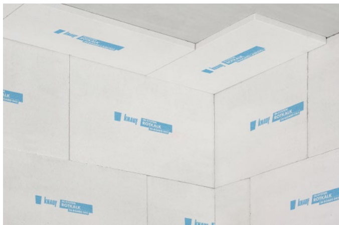
Bild 9: Dämmung von einbindenden Bauteilen
