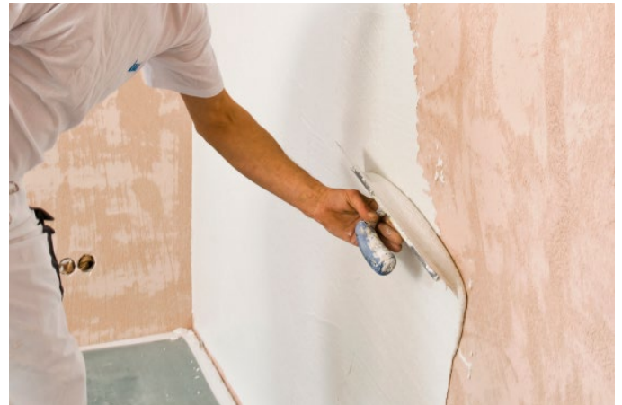
Bild 22: Auftrag des Oberputzes
