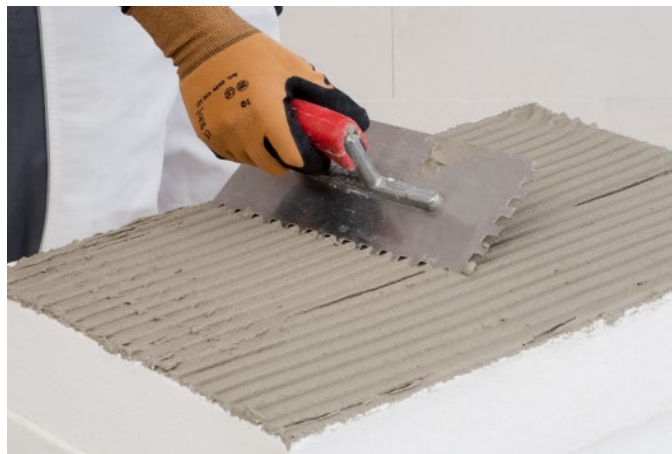
Bild 4: Aufziehen des Rotkalk in-Klebemörtel TecTem
