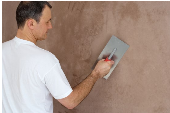
Bild 1: Untergrundvorbereitung von massiven Wänden
