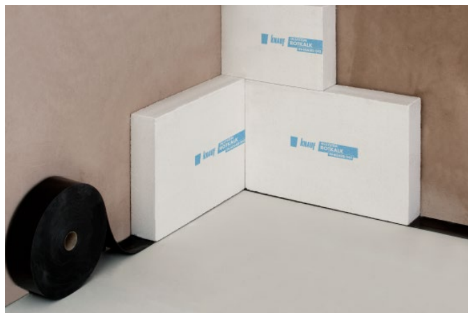
Bild 3: Einbau des Dichtungsbandes
