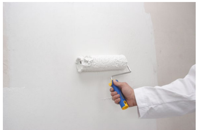
Bild 23: Schlussbeschichtung
