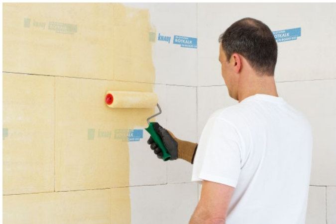
Bild 16: Grundierung
