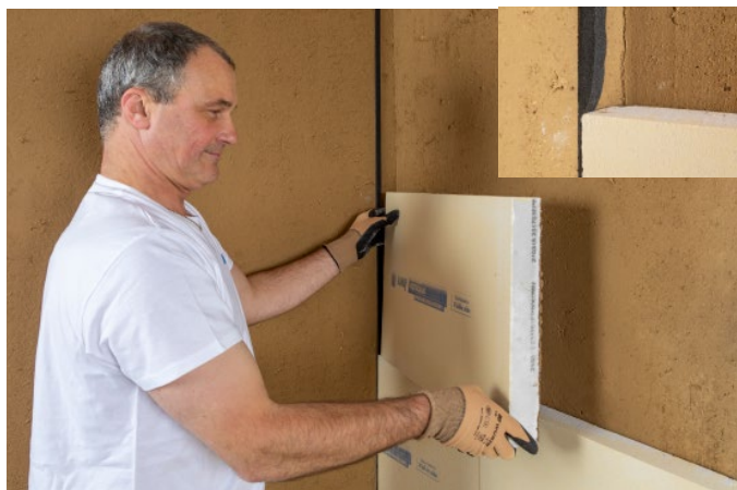
Bild 10: Fachwerk: einbindende Innenwand
