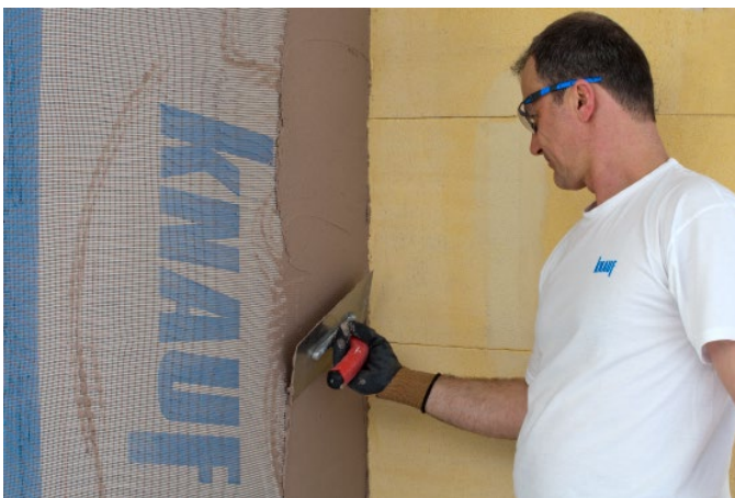
Bild 21: Einbetten des Flächengewebes
