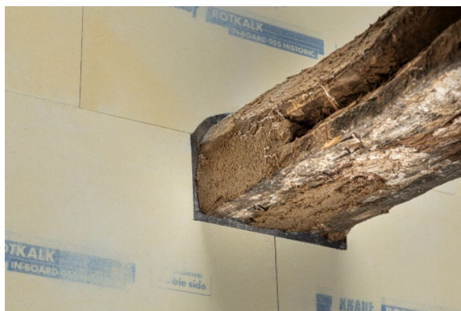
Bild 12: Fachwerk: Bereich Holzbalkendecke
