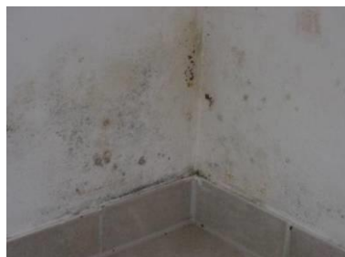
Schimmelbildung aufgrund Kondensatbildung im Keller
