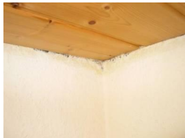
Wärmebrücke – Decke zum ungedämmten Dachgeschoss
