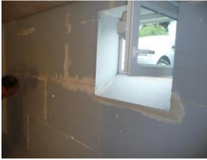
Wandöffnungen mit Pistolenschnitt herstellen. Platten im Versatz verlegen.
