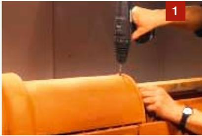
First mit Dichtungsschraube befestigen.
