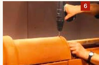
First mit Dichtungsschraube befestigen.
