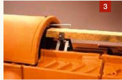
Der Sicherungsstab zeigt schräg nach oben.
