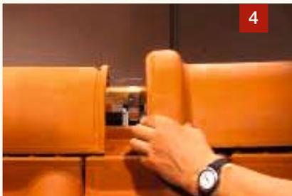
Nächsten first heranschieben und beim Einfädeln auf den Sicherungsstift leicht über die Aufkantung heben.
