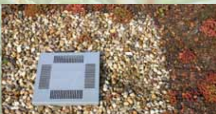
Entwässerungsschicht Mit Kieseinfassung.
